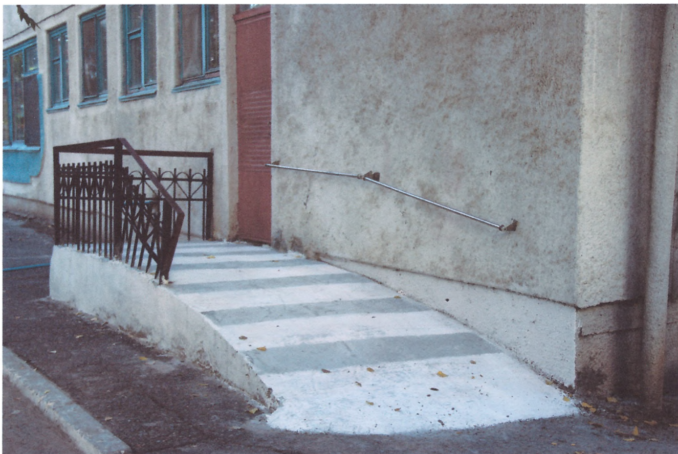
Фото №5 Вход в здание(пандус наружный)
