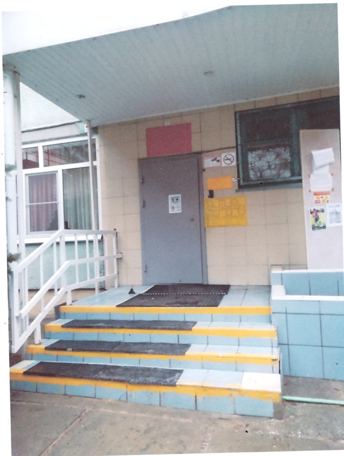
Фото №6 лестница наружная
