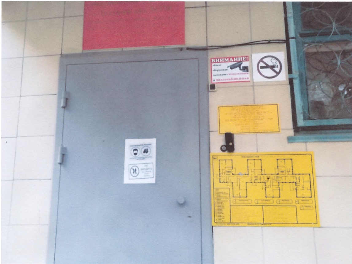
Фото №7 Дверь (входная)
