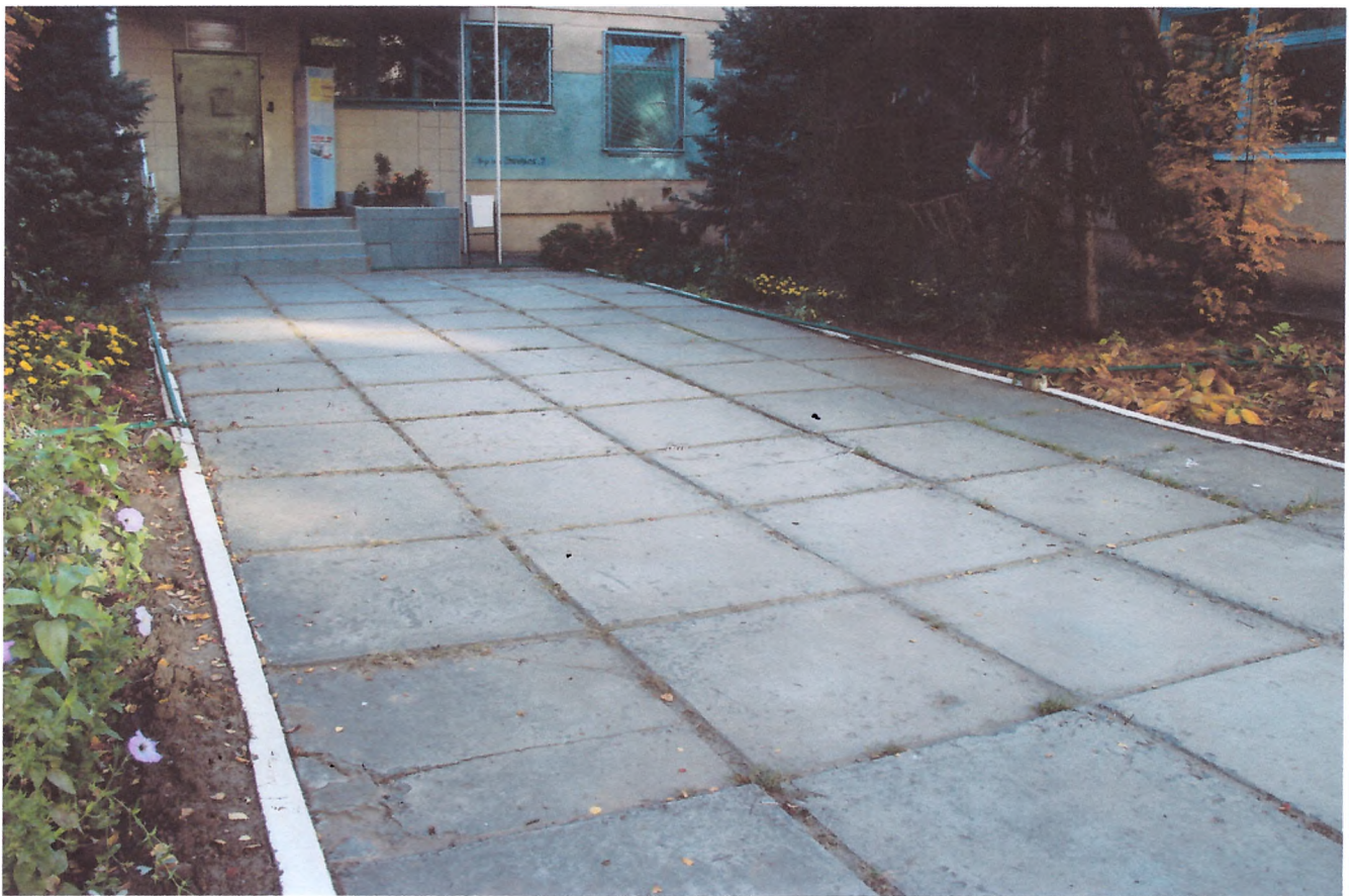
Фото №8 Входная площадка (перед дверью)
